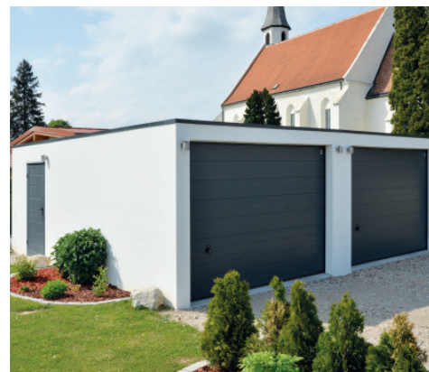
Doppelgarage mit zwei Sektionaltoren und Nebeneingangstüre.
